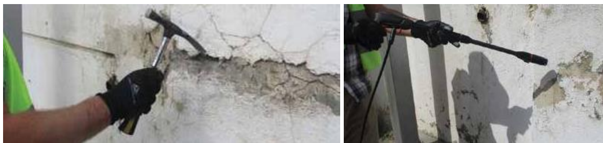
Figura 15 Exemplu curatare pereti exteriori cu tesla si cu un aparat de spalat cu presiune
